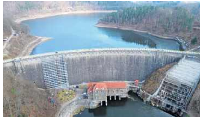
Remont tamy potrwa dwa lata. Aby zrealizować prace wybudowano potężne rusztowanie
