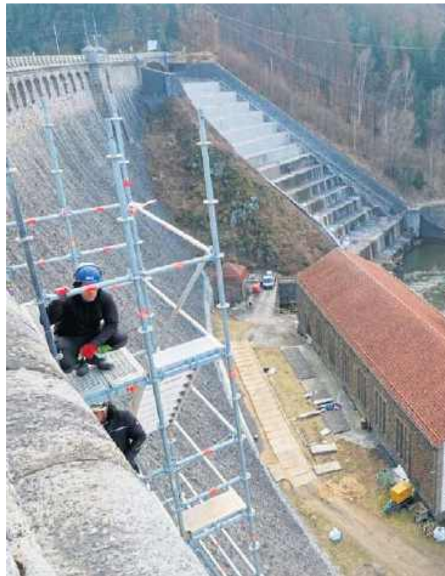
Rusztowanie będzie przesuwane wraz z postępowaniem prac
