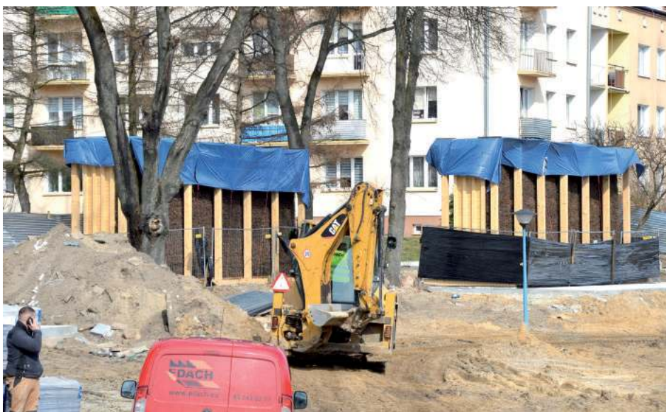
Tężnie mają prawie 11 m długości, ponad 4 m wysokości i 3 m szerokości
