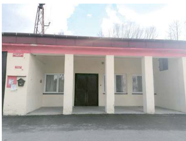
W przeszłości remiza była kilkakrotnie rozbudowywana. Dziś o gruntowną modernizację aż się prosi
