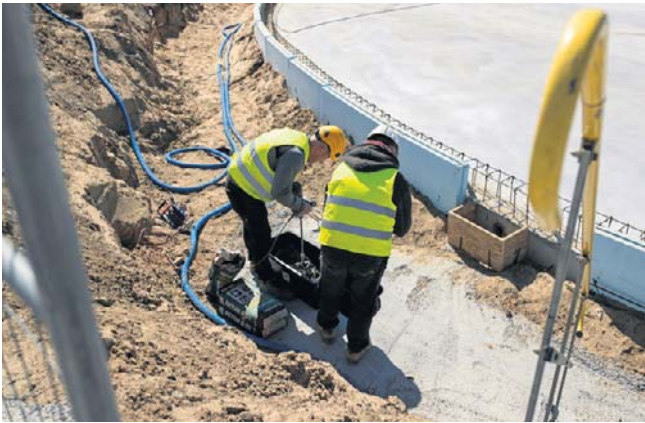
Początek budowy biogazowni spółki ProNatura - kwiecień 2026 roku
