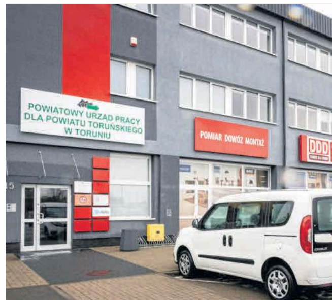
Siedziba Powiatowego Urzędu Pracy przy ul. Polnej 115w Toruniu
