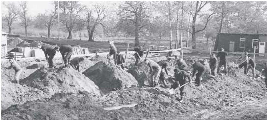
Przy budowie obecnej siedziby Szkoły Podstawowej w Markuszowie pracowali okoliczni mieszkańcy w ramach tzw. czynu społecznego
