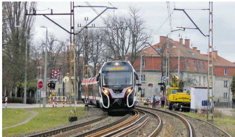
• Remont torów na trasie Warszawskiej Kolei Dojazdowej, 26 marca 2026 r. FOT. WKD
