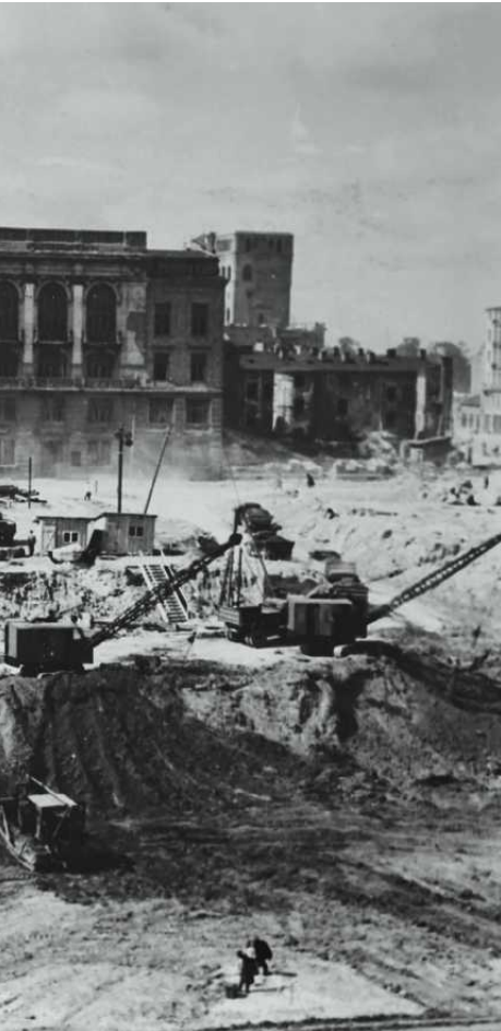
◀ 2.05.1952 Koparki rozpoczynają pracę na budowie. Potrzebny sprzęt zaczęto zwozić z ZSRR od kwietnia. Pierwszy wykop pod fundament był gotowy w połowie czerwca FOT. REPRODUKACJA Z KRONIKI PKiN/ WAL-DEMAR GORLEWSKI / AGENCJA WYBORCZA.PL
