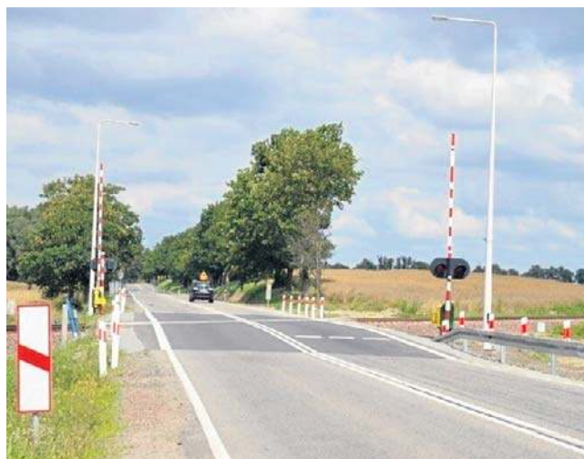
Przy okazji przebudowany zostanie przejazd kolejowy
