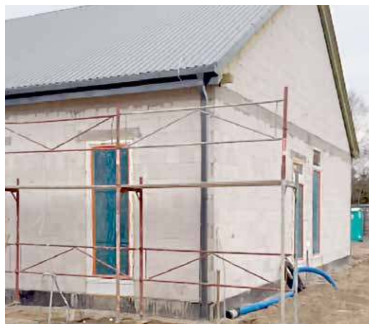
Miejski Żłobek jeszcze w budowie
