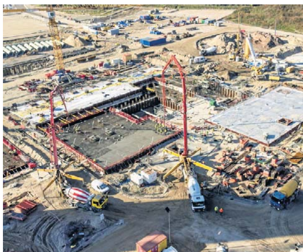
Prace fundamentowe na budowie elektrowni w Gdańsku
