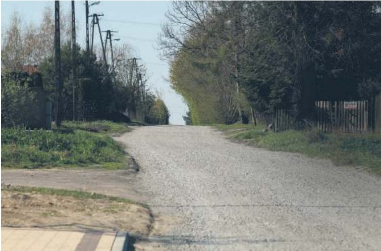
Wyrównanie kruszywem to dopiero początek inwestycji na ulicy Drewnianej
