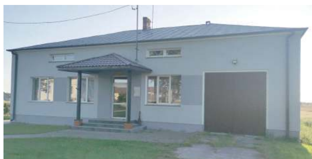
Remontu doczekała się już świetlica w Żeliźnie
