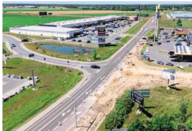
Tak powstaje wyczekiwane rondo przy stacji Shell
