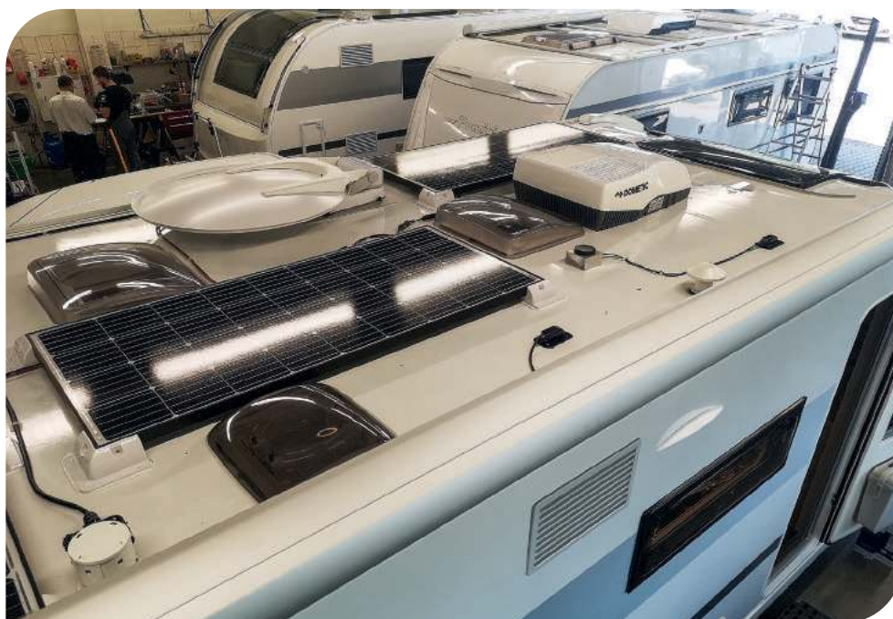
Panele fotowoltaiczne zamontowane w serwisie Elcamp na przyczepie Adria Adora 673 PK
