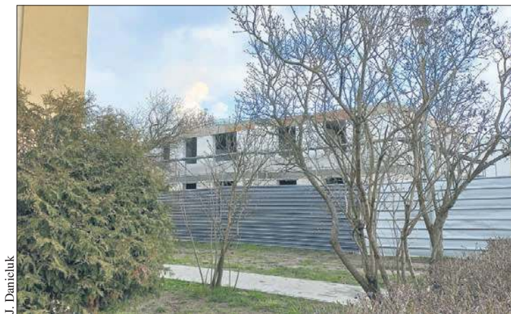
Cały czas trwają prace budowlane na osiedlu Miodowa Jar
