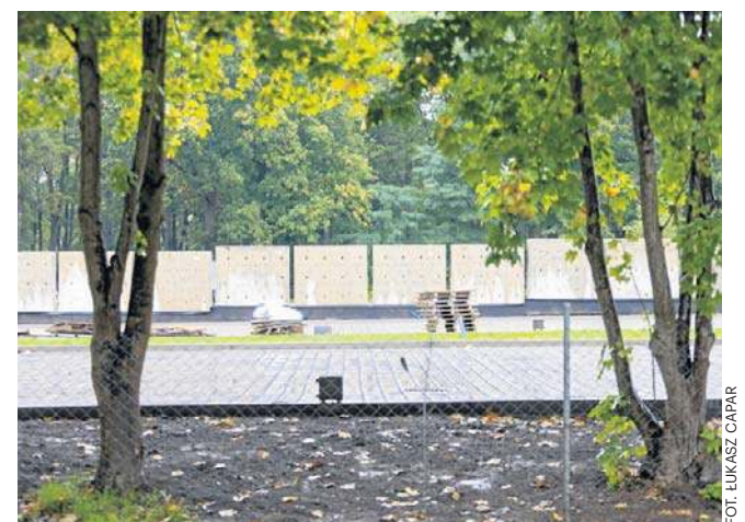
Postępy prac przy budowie kolumbarium
