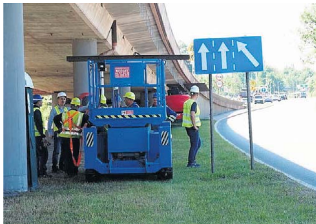
Prace obejmują konserwację, naprawę lub wymianę każdego elementu ponad półkilometrowej konstrukcji
