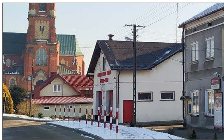
Wyremontowana zostanie m.in. remiza OSP w Siedliskach-Bogusz.
