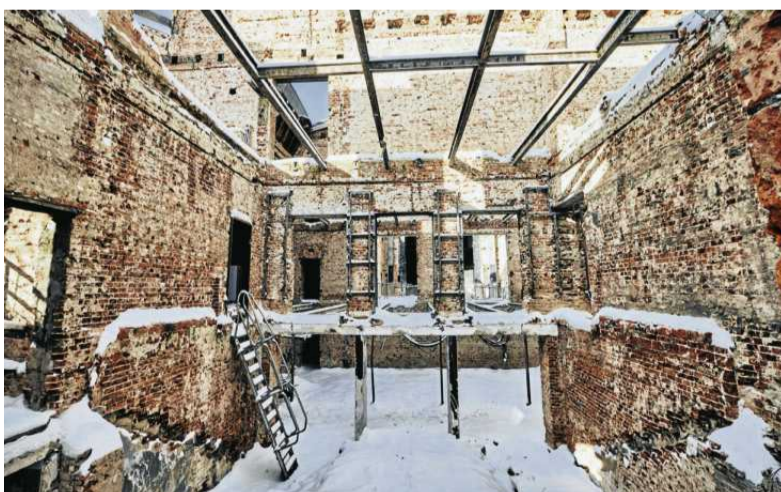
• Z budynku teatru zostały jedynie ściany FOT. TOMASZ STAŃCZAK / AGENCJA WYBORCZA.PL
