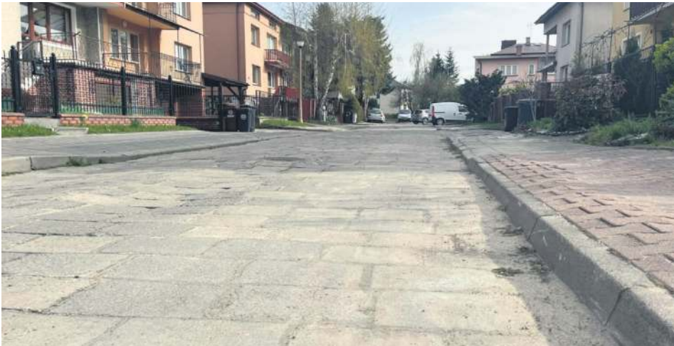
W ramach inwestycji zaplanowano przebudowę fragmentu ul. Grabowej, który dotychczas nie był modernizowany.
