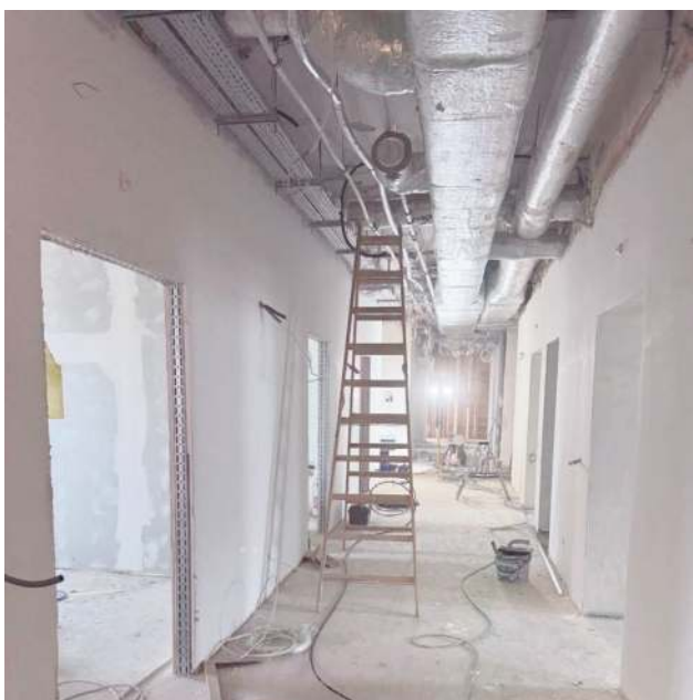
Nowy Zakład Opiekuńczo-Leczniczny dla pacjentów wentylowanych mechanicznie w Szpitalu Miejskim przy ul. Peowiaków w Zamościu wchodzi właśnie w etap prac wykończeniowych.
