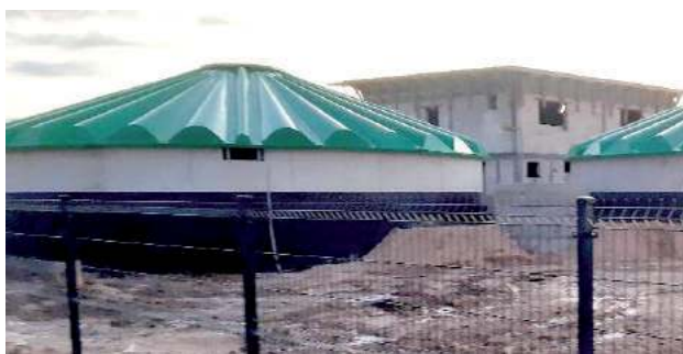
Oczyszczalnia w Gołaszynie ma być gotowa do końca 2022 r. Tu trafia nieczystości z sieci kanalizacyjnej w Wólce Świątkowej, Rolach i Krynce za pomocą nowego kanału sanitarnego
