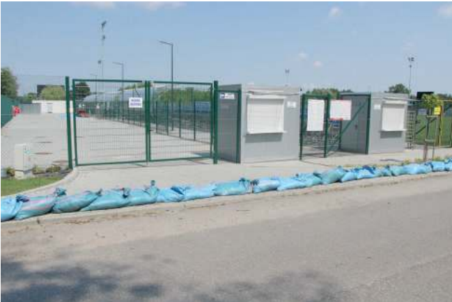
Falochron z worków ciagle broni stadionu w oczekiwaniu na kolejny deszcz
