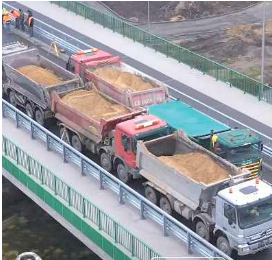
Próba obciążeniowa nowego mostu na Krznie
