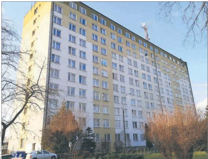
W płockim „Wcześniaku” będzie gruntowny remont za ponad 3 mln zł
