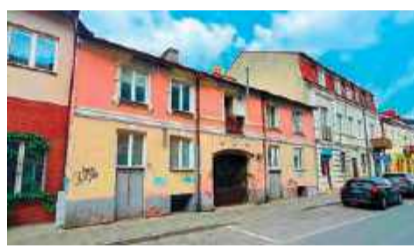
Kamienica przejdzie gruntowny remont
