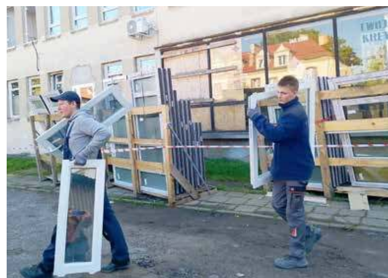
Prace ogólnikują się obecnie przy samym budynku laboratorium
