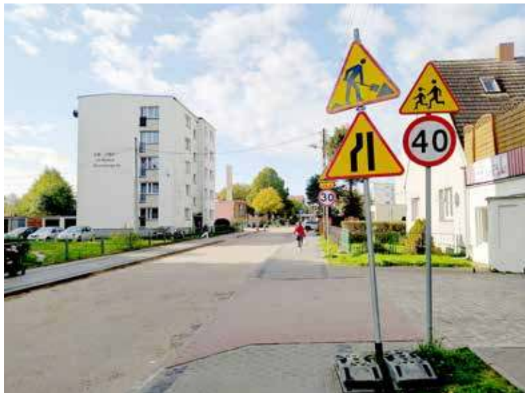
Na Żeromskiego już niedługo będzie lany asfalt
