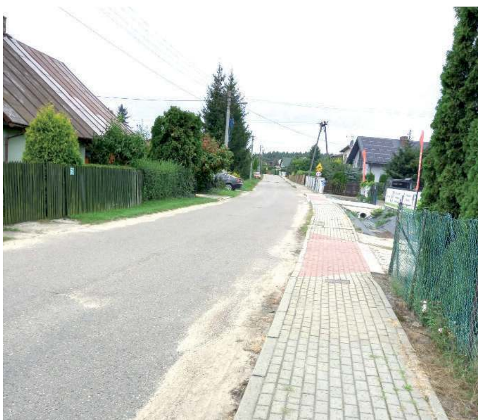
Droga w Zalesiu będzie gruntownie wyremontowana
