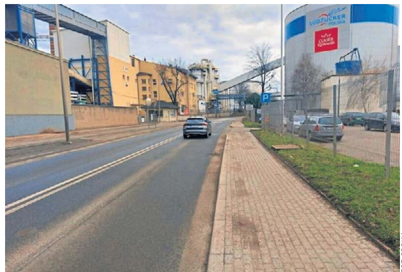
W poniedziałek 17 sierpnia ruszył remont drogi krajowej nr 45 w Ciężkowicach.
