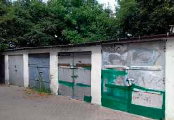
Obskurne i nieużytkowane garaże szpecą zadbaną okolicę
