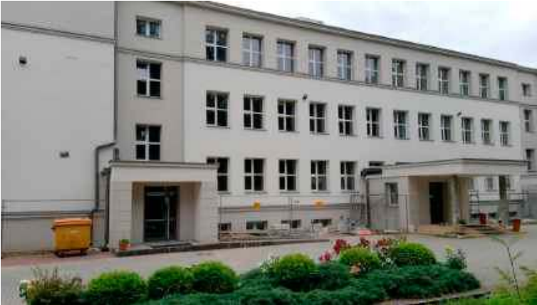
Termomodernizacja SP nr 6 dobiega końca
