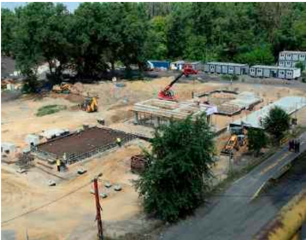
Budowa już ruszyła. Nowy blok energetyczny ma być gotowy do 31 marca 2023 roku
