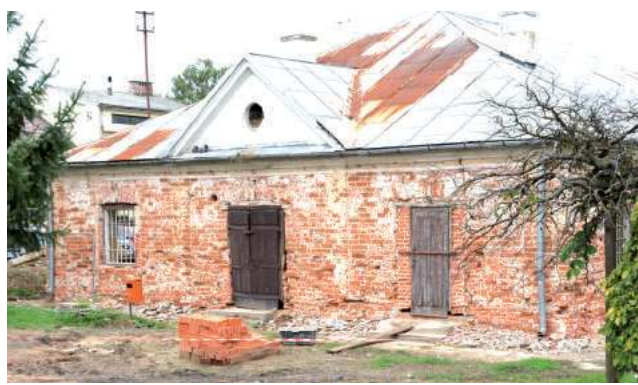
Spod tynku wyjrzały ceglane ściany
