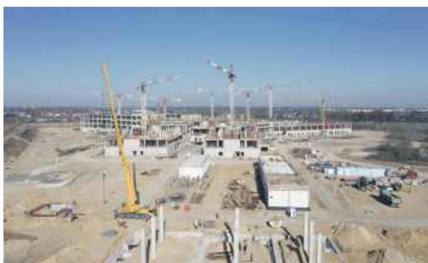
Budowa Nowego Szpitala Onkologicznego przebiega bardzo sprawnie i wyprzedza harmonogram
