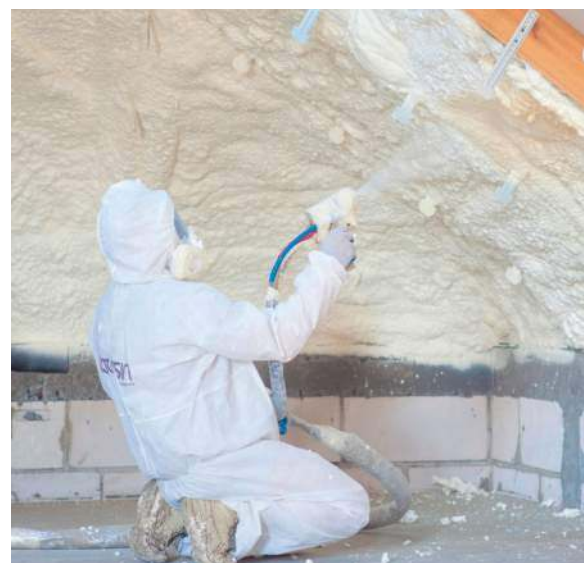
Zastosowanie pianki poliuretanowej do ocieplenia dachu znacznie zwiększa tempo remontu. PCC PRODEX
