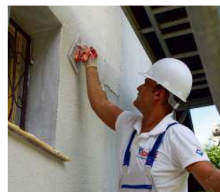
10 Nałożenie tynku cienkowarstwowego.
