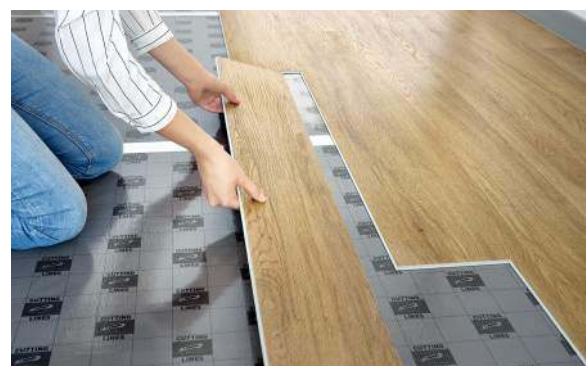
🔧 Układanie paneli winylowych (bez użycia kleju) na płytkach ceramicznych. DECORA (ARBITON)
