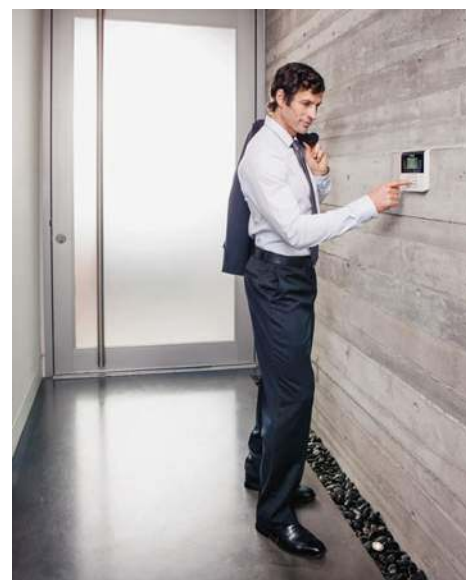
🔧 Manipulator umieszcza się w łatwo dostępnym miejscu, np. przy drzwiach wejściowych, aby móc szybko wydać polecenie centrali alarmowej. BOSCH SECURITY
