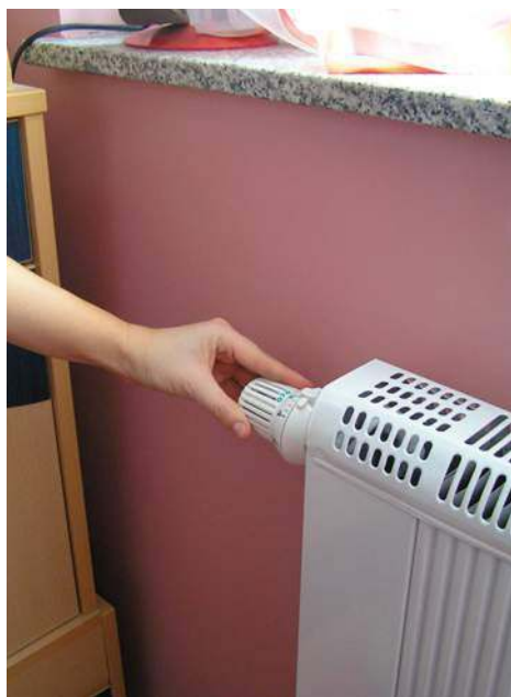
🔗 Głowice termostaticzne to końcowy element systemu sterowania ogrzewaniem. REGULUS-SYSTEM
