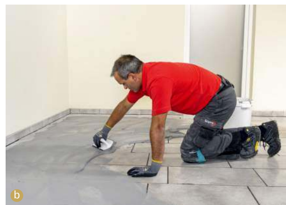
🔧 Naprawa miejscowych uszkodzeń w płytkach przed ułożeniem na nich nowych kafli (a Ceresit), spoinowanie nowej posadzki (b SOPRO).
