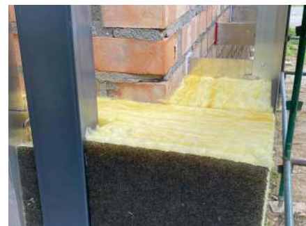
Do ocieplania ścian stosuje się płyty z wełny mineralnej półtwarde i twarde. PAROC, URSA
