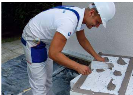
2 Nanoszenie kleju na płyty styropianowe.
