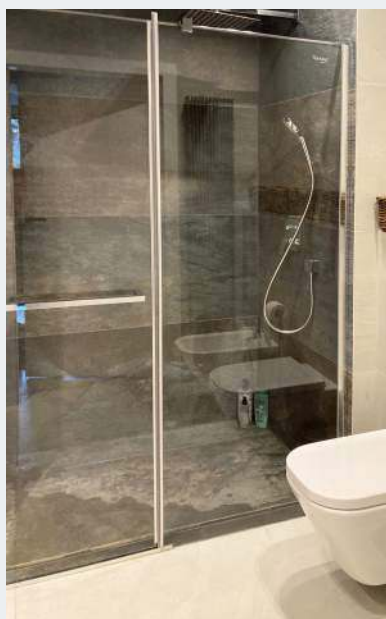
Wzdłuż przeszklenia osadzono szczelinowy odpływ liniowy (120 cm).
