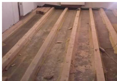
🔧 Wymienienie elementów konstrukcyjnych. T. RYBARCZYK
