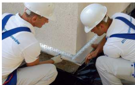
1 Skompletowanie materiałów, sprzętu i rusztowań, zdjęcie obróbek blacharskich i orynnowania. Montaż listwy startowej.
