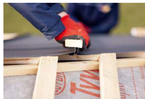
Wymiana pokrycia – panel na rąbek stojący. BLACHY PRUSZYŃSKI
