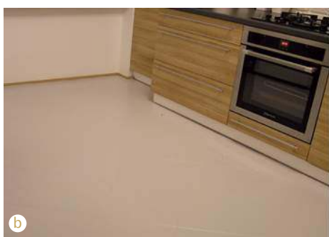
🔧 Nanoszenie farby na wcześniej wyczyszczone i zagruntowane płytki ceramiczne (a). Pomalowana posadzka w kuchni (b). NOXAN
