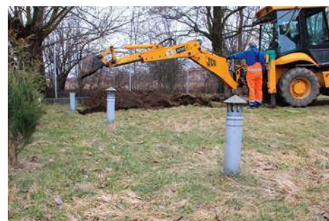
🔦 Remont drenażu oznacza konieczność rozkopania ogródka. J. WERNER
