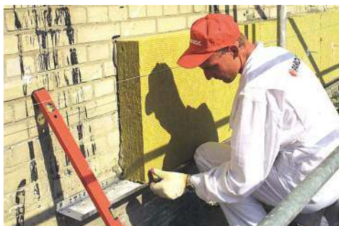
Do ocieplania ścian stosuje się płyty z wełny mineralnej półtwarde i twarde. PAROC, URSA
