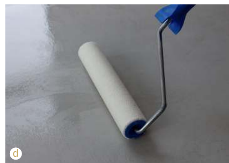
🔧 Kolejne etapy wykonywania posadzki z mikrocementu – gruntowanie (a), nakładanie mikrocementu (b), szlifowanie (c), lakierowanie (d). BAUTECH
