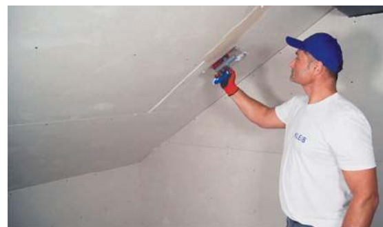
🔗 Montaż płyt gipsowo-kartonowych (suchego tynku) na profilach stalowych pozwala na docieplenie przegrody (umieszczenie w niej izolacji z wełny mineralnej). KNAUF
