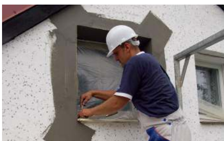
7 Obróbka narożników okiennych.
