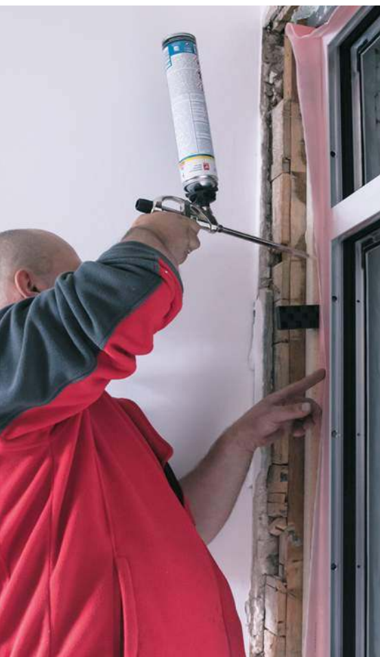
❶ Standard montażu drzwi jest podobny jak w przypadku okien – tu też używa się zarówno pianki, jak i taśm zabezpieczających. KAMPANIA EDUKACYJNA DOBRY MONTAŻ
