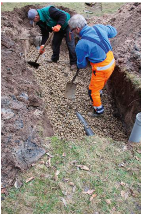
❗ Rury drenarskie układa się na grubej warstwie kruszywa, a od góry również zasypuje płukanym żwirem. J. WERNER
