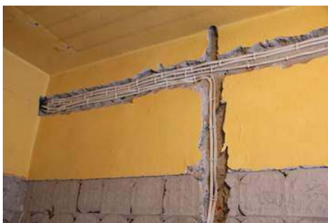
🔧 Układanie nowej instalacji to zwykle dużo kucia, dlatego najlepiej połączyć je z większym remontem. J. WERNER
