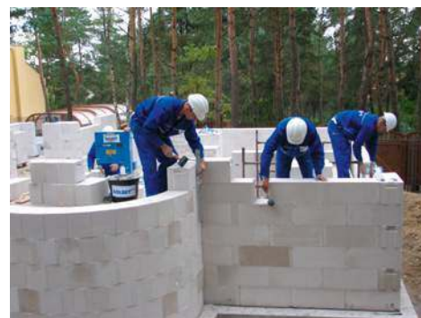
🔧 Stosując łatwe w obróbce elementy murowe można uzyskać ściany o pożądanym kształcie, np. zaokrąglone. SOLBET
