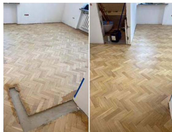
Odnowienie parkietu przez cyklinowanie i lakierowanie oraz uzupełnienie miejsc po wyburzeniu ścian. BRIGADEPRO.PL
