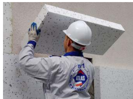
3 Przyklejanie płyt do ściany.
