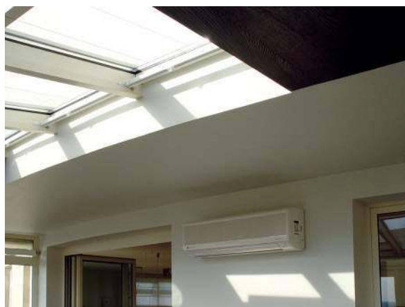
🔥 Klimatyzator umożliwia szybkie schłodzenie oranżerii w gorące dni. Zimą można dogrzewać nim pomieszczenie. REYNAERS POLSKA
