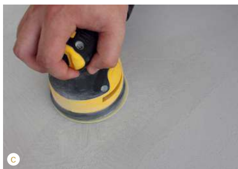
🔧 Kolejne etapy wykonywania posadzki z mikrocementu – gruntowanie (a), nakładanie mikrocementu (b), szlifowanie (c), lakierowanie (d). BAUTECH
