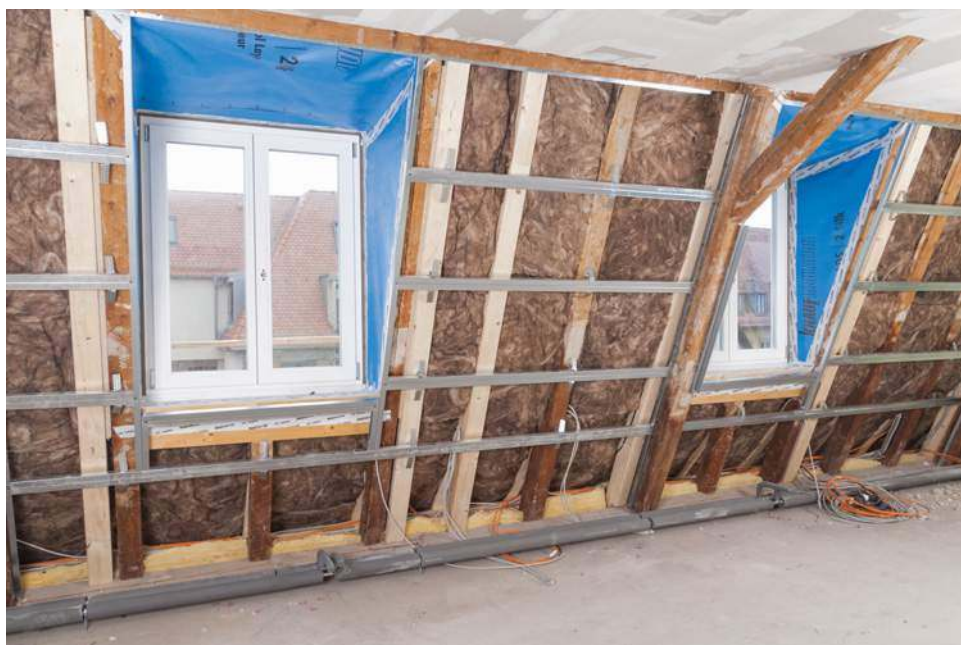
Poddasze w trakcie adaptacji – wzmocniona więźba dachowa, nowe ocieplenie i stolarka okienna. KNAUF INSULATION
