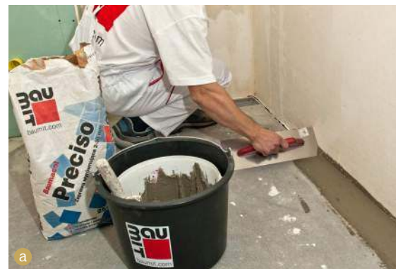
🔧 Naprawa miejscowych uszkodzeń w płytkach przed ułożeniem na nich nowych kafli (a Ceresit), spoinowanie nowej posadzki (b SOPRO).
