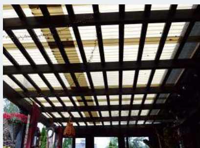
🔥 Na dachu są przydymione trapezowe płyty z poliwęglanu, boczne ściany drewnianej konstrukcji wypełniają okna skrzynkowe ze starego dworku.
