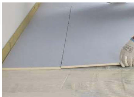
🔧 Ułożenie podkładu z płyt drewnopodobnych przed wykończeniem posadzki. KRONOPOL, KNAUF
