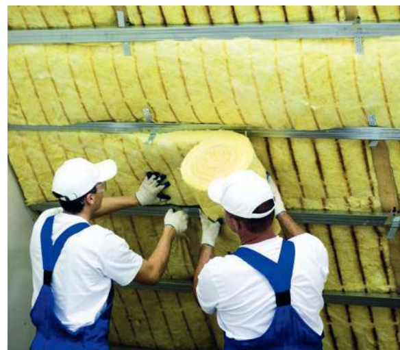
Ocieplenie poddasza wełną mineralną. URSA
