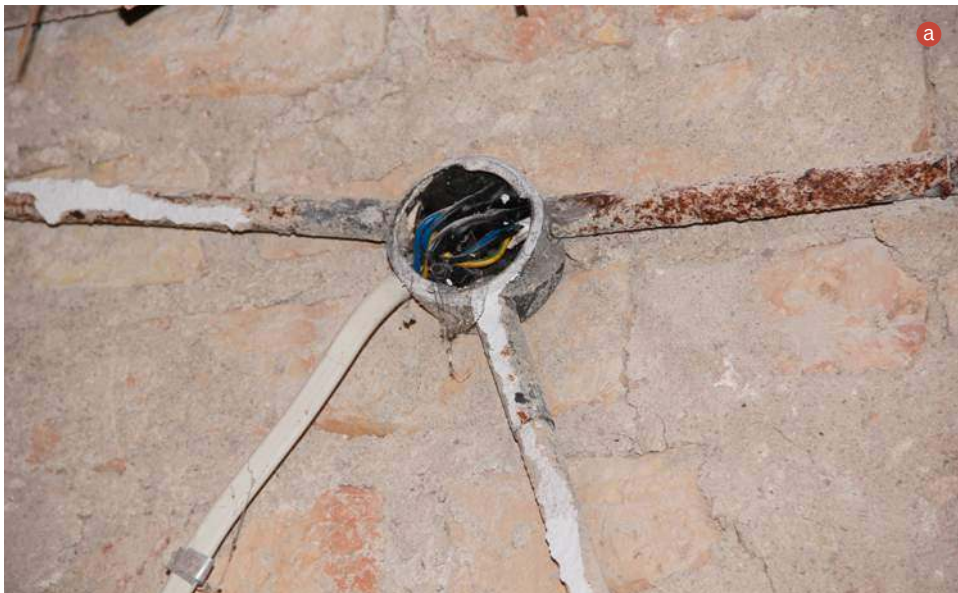
⚡ Puszka rozdzielcza w bardzo starej instalacji (a) i współczesna instalacja bezpuszkowa (b). J. WERNER
