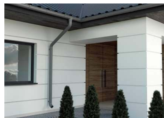
➏ Ocieplone elewacje najczęściej wykańcza się tynkiem cienkowarstwowym w jasnym kolorze, urozmaiconym dekoracyjnymi boniami. BELLA PLAST
