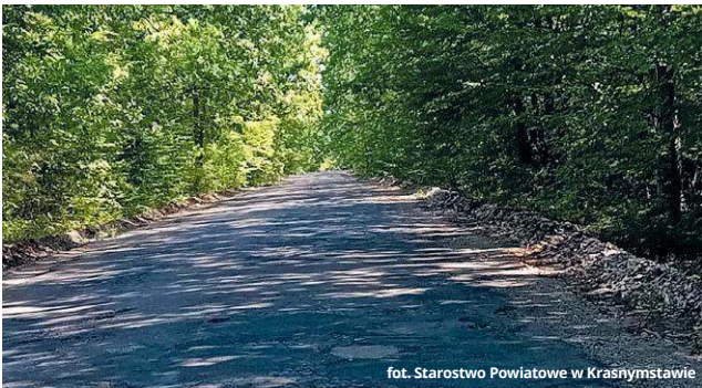
Prace przy remoncie drogi powiatowej. Fot. Starostwo Powiatowe w Krasnymstawie
