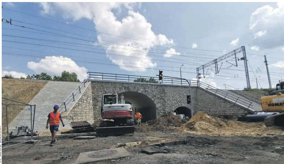
Wiadukt na ul. Siennej w Chrzanowie
