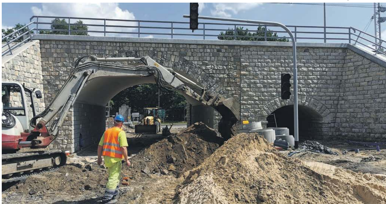
s. 3 Prace przy wiadukcie kolejowym na ul. Siennej w Chrzanowie
