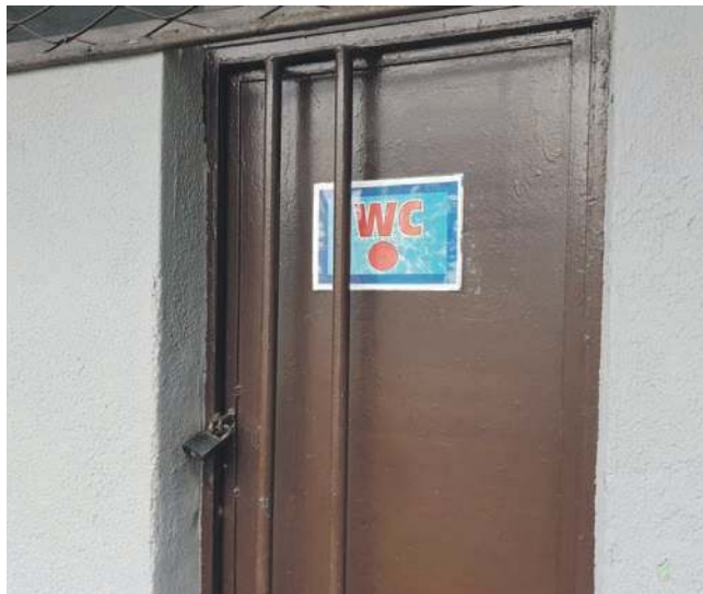
Zamknięte na kłódkę toalety na terenie Miejskiego Ośrodka Rekreacyjno-Sportowego w Libiążu
