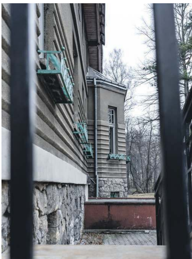
Fragment elewacji z wejściem do dawnej kawiarni
