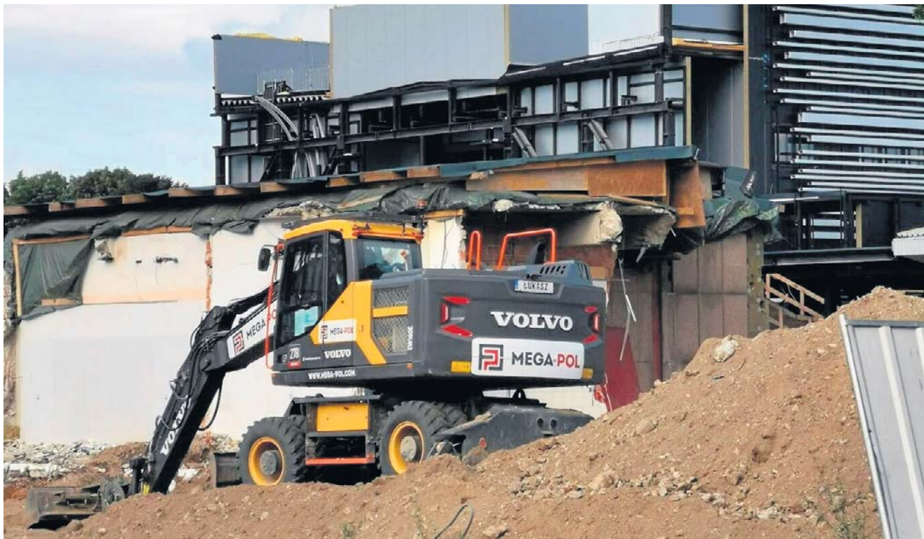
Nowa wieża zegarowa rośnie przy dworcu PKP w Częstochowie. Tu będzie główne wejście
