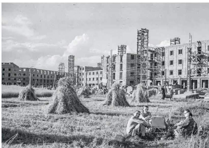
Na budowie osiedla mieszkaniowego w Nowej Hucie, lipiec 1953 r.
