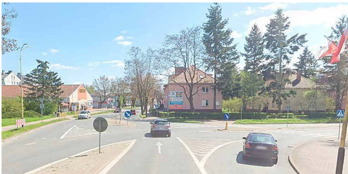
Uzbiegu ul. 3 Maja i 700-lecia planowane jest rondo. Dokumentacja ma być gotowa w przyszłym roku
