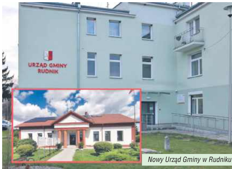
Szkoła w Rudniku po termomodernizacji
