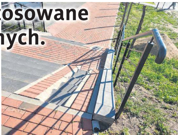
Poręcz została zamontowana po zewnętrznej stronie.
