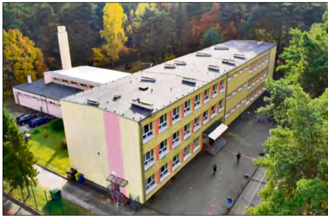
Wniosek o termomodernizację budynku został złożony przez gminę w 2024 roku.
