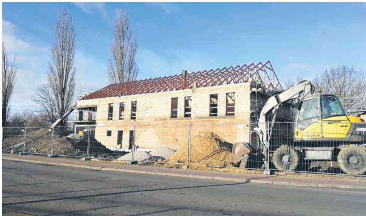
Koszt budowy komisariatu to 4 mln zł
