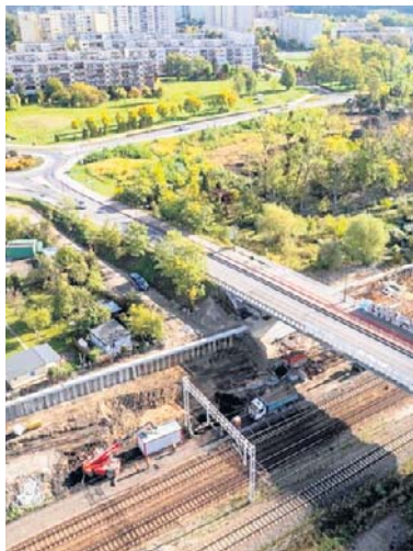
W rejonie Estakady Heweliusza już ruszyły prace budowlane
