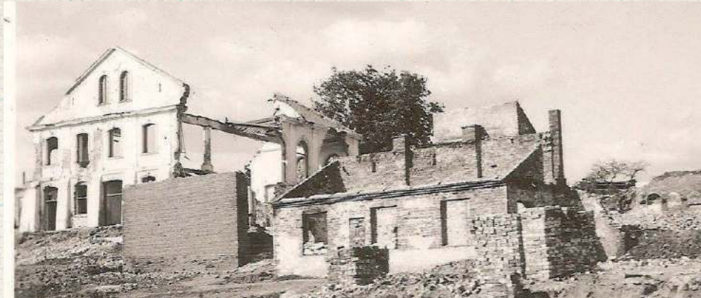
Zburzona synagoga „nowa” (z lewej). Zdjęcie z profilu fb „Dawne Puławy”
