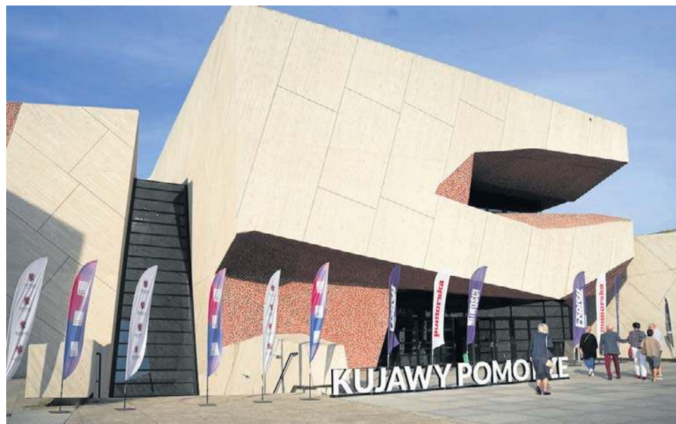
Podziemny parking pod CKK „Jordanki” to jedno z miejsc schronienia dla mieszkańców Torunia w wypadku zagrożenia
