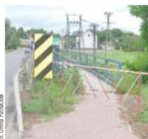
Remontowana kładka na rzece Świnka
