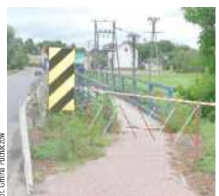
Remontowana kładka na rzece Świnka
