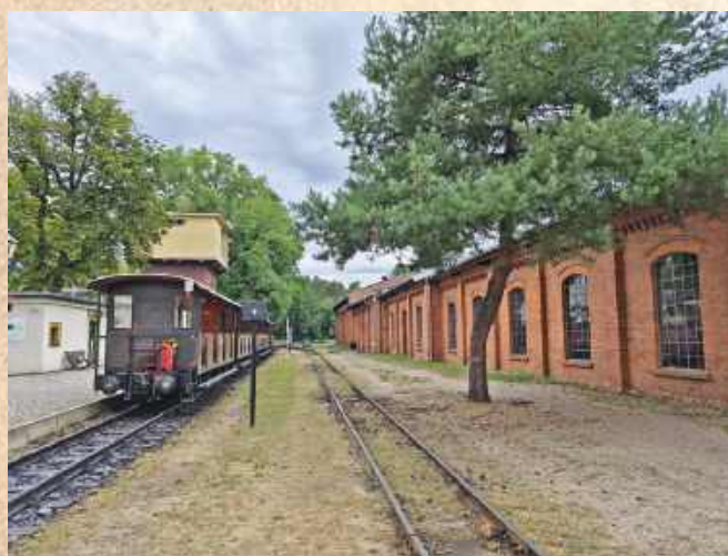
■ 57 tysięcy pasażerów, wydarzenia przez cały rok i plany odbudowy kolejnych kilometrów torów. Rudzka kolej przeżywa drugie życie, choć jej utrzymanie wymaga ogromnej pracy i pieniędzy.
