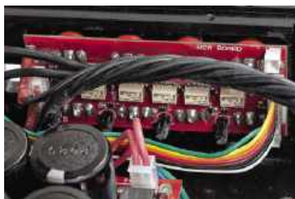
Skróceniu ścieżki sygnału pomagają selektor wejść z przekaźnikami, umieszczony niedaleko gniazd RCA.
