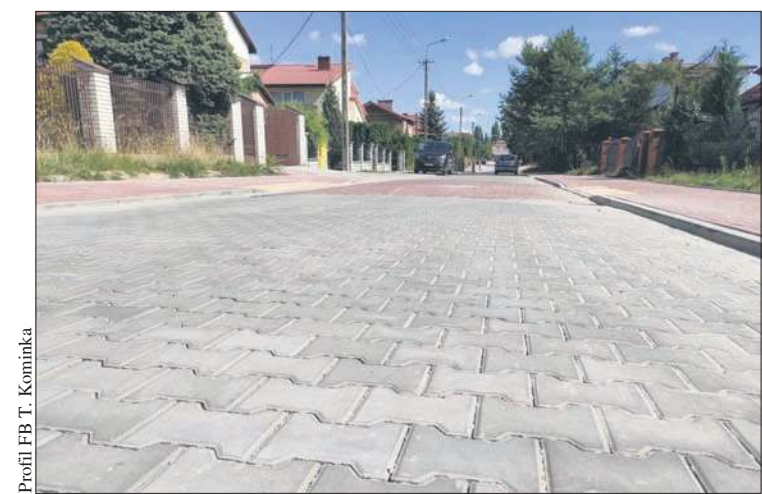
W Radziwiu trwa budowa ulic Teligi, Kapitańskiej, Szkutniczej i Żeglarskiej oraz kolejnego zbiornika retencyjnego
