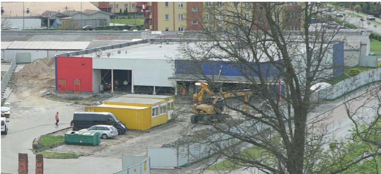
Trwa przystosowanie hali po Tesco do potrzeb Lidla
