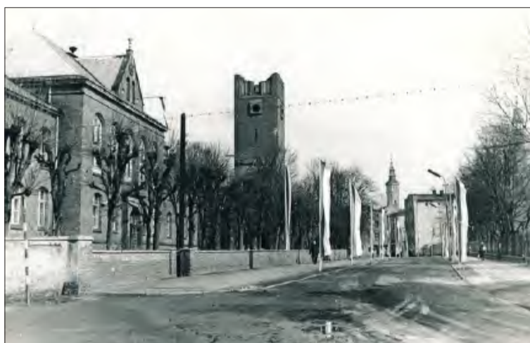
Kościół w trakcie rozbiórki. Demontaż budowli prawdopodobnie nie trwał jeden sezon, stąd można spotkać rozbieżne daty dotyczące likwidacji budowli.
