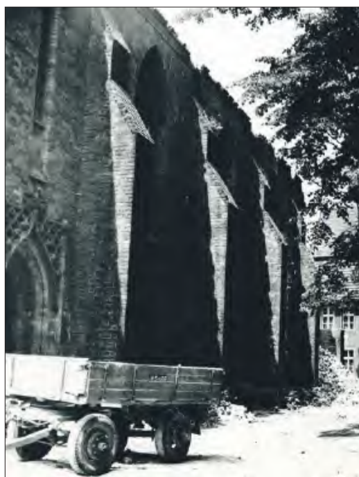
Cegły z rozbiórki były cennym materiałem budowlanym
